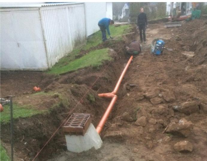
von Kevin Menke wurden Abflüsse eingebaut, Kanalrohre verlegt, Randsteine gesetzt und dann das eingebaute Material verdichtet. Dann ging es daran,
